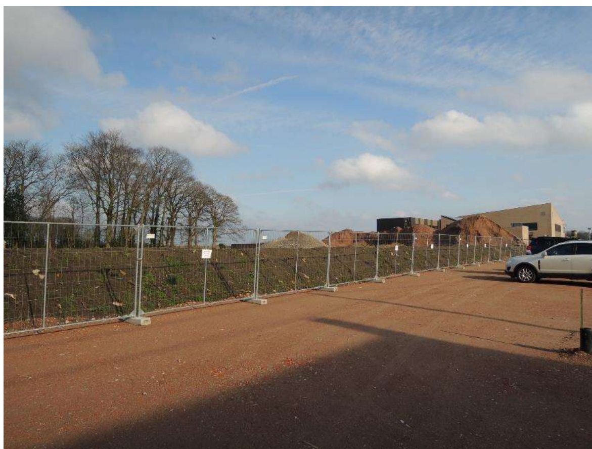
Omliggende klooster afgebroken in 2016.
