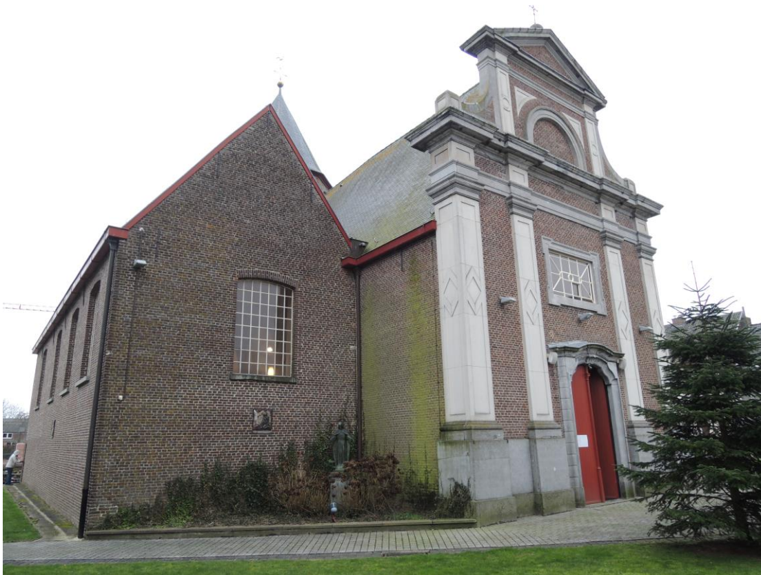
Westelijke portaal met 18de-eeuwse poortomlijsting.
